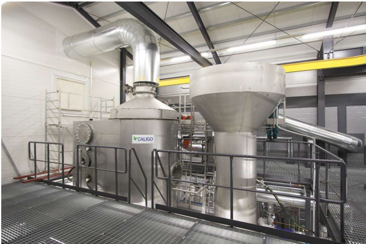
Kuva 5. Caligo Industria Oy:n valmistama savukaasupesuri, joka sisältää savukaasujen pesun lisäksi lämmön talteenoton ja likaisen lauhteen puhdistuksen (Kuva: Caligo Industria).
