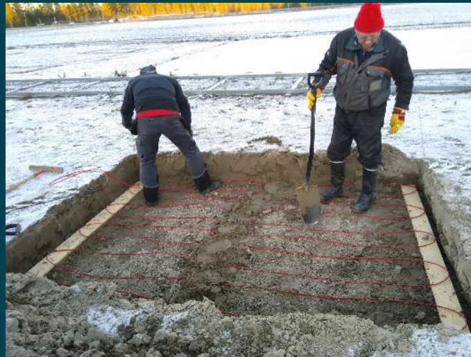
Maalämmityskaapeleiden asennus
